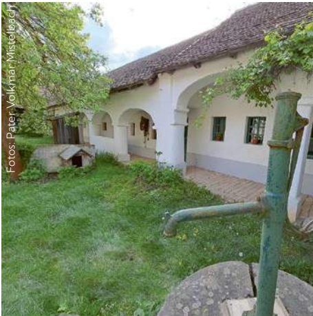
Die „Trettn“ ist ein überdachter Gang zu den Stallungen
